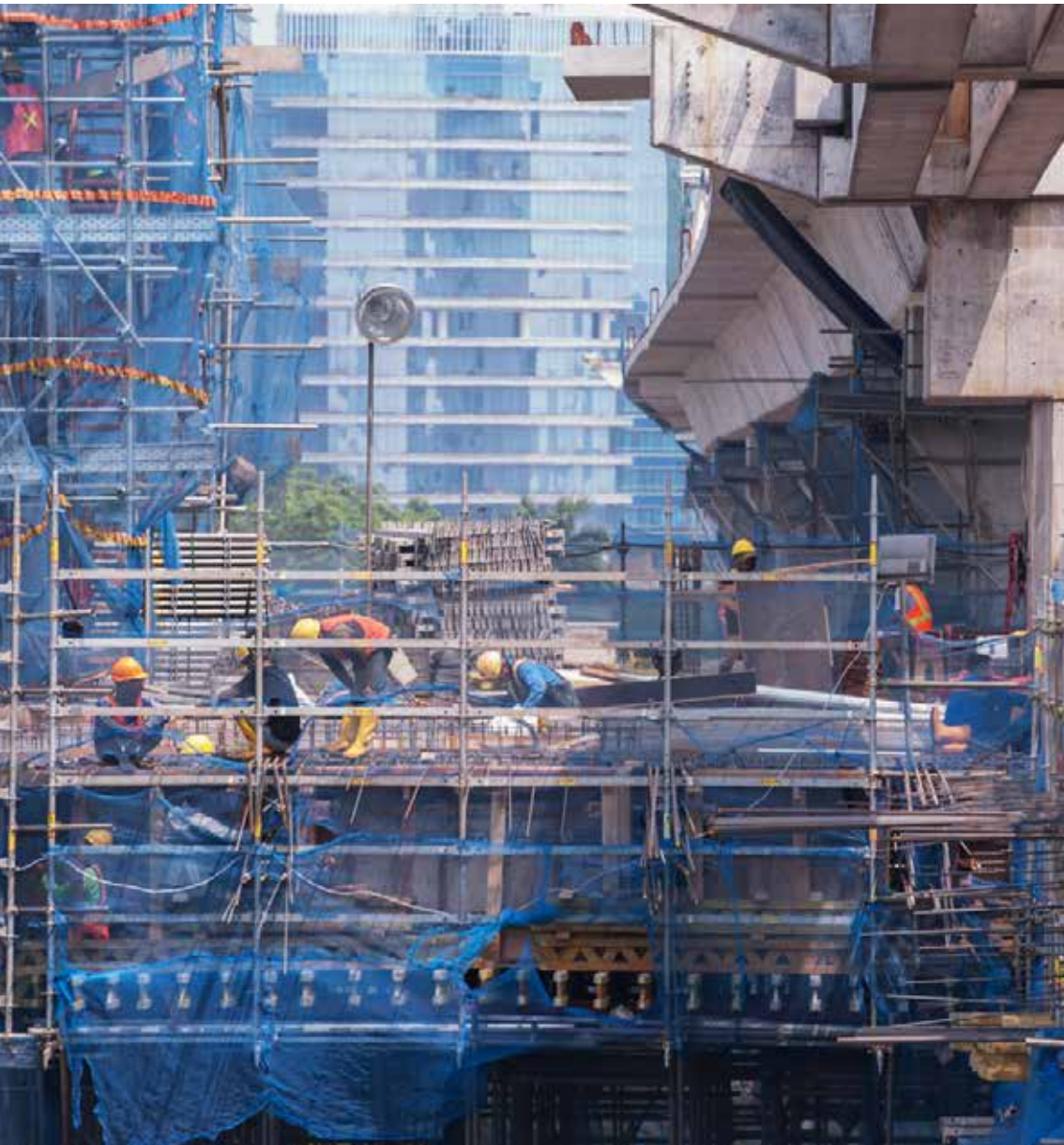
⇧ Pengerjaan tiang kolom jalur layang di dekat bakal Stasiun Fatmawati, 22 Agustus 2017. Dok. PT MRT Jakarta/Irwan Citrajaya.
