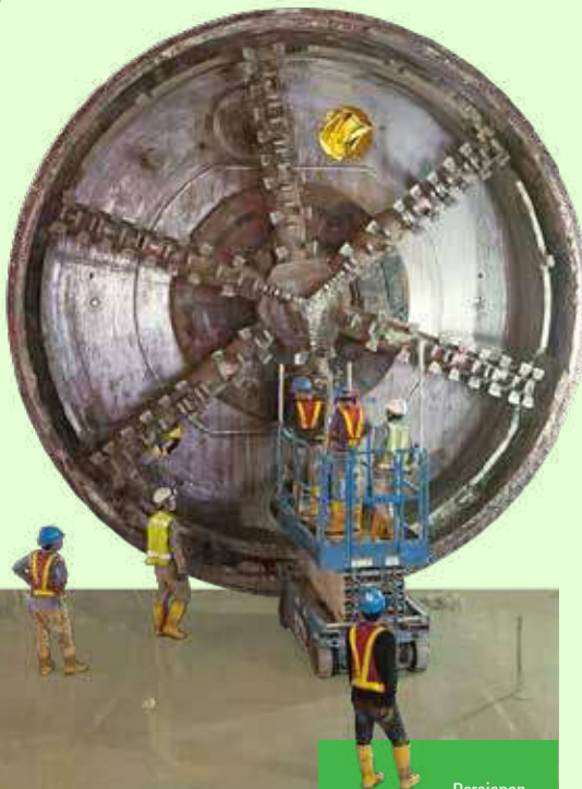
Persiapan pembongkaran TBM di area konstruksi bawah tanah Stasiun Setiabudi, 20 Februari 2017. Dok. PT MRT Jakarta/ Irwan Citrajaya.
